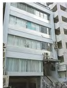
御徒町にあるKGKグループの日本本社ビル
